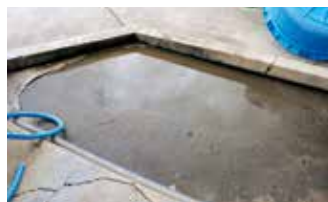
様々な箇所老朽化に伴う、ひび割れなどが目立つ
