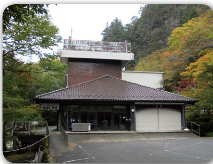
解体予定の国民宿舎面河
