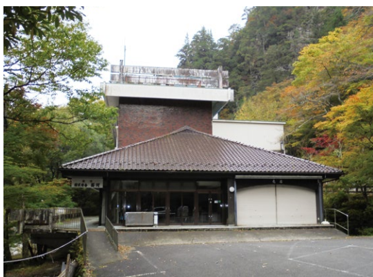
解体予定の国民宿舎面河
