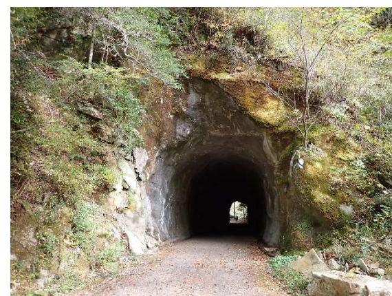
④鉄砲石川隧道
