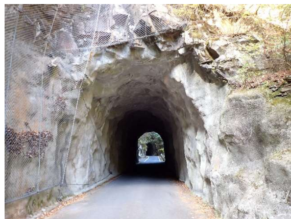
②関門第2トンネル
