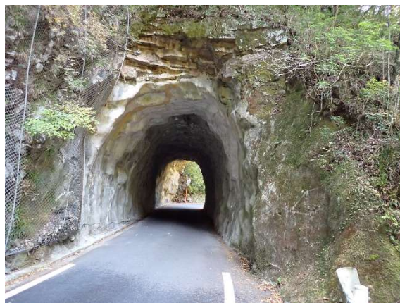
③関門第3トンネル
