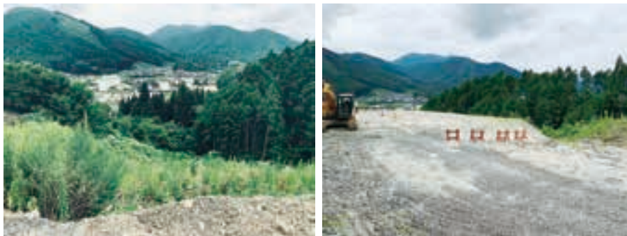
菅生地区建設残土処理場予定地
