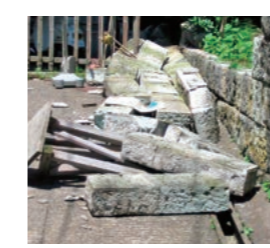
(一財)消防科学総合センター
