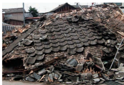
(一財)消防科学総合センター
