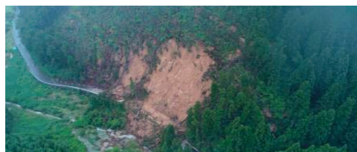
7月豪雨(写真提供:久保建設)
