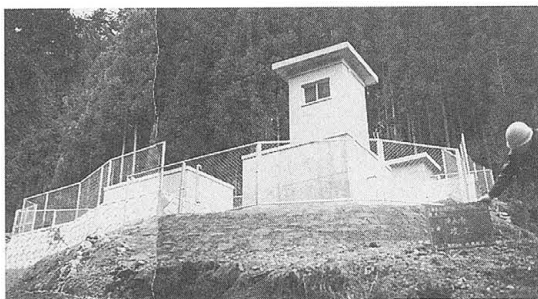
田波野瀬共同給水施設
