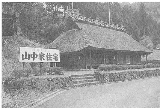
国指定重要文化財「旧山中家住宅」
