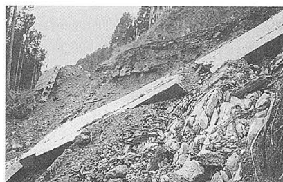
災害林道復旧工事 被災時（林道水押イショブネ線）平成4年10号台風
