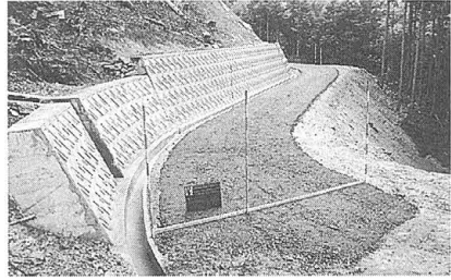
山振林道上黒岩線開設工事
