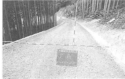
林構林道 内分線 開設工事
