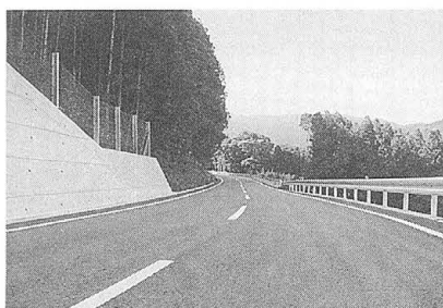
(生活道改良)で改良工事が進んでいる (一) 柳谷・美川線
