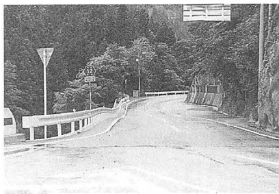
(高桟幹線道)で改良工事が進んでいる 滝渡瀬附近 (主) 西条・久万線
