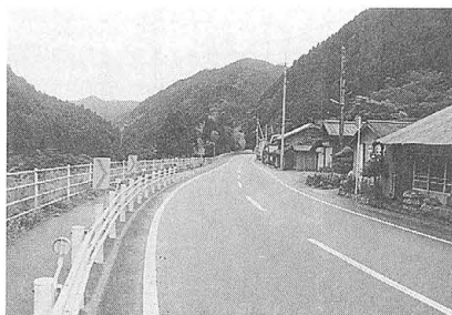
(道改)で改良された西古味集落内 (主) 西条・久万線
