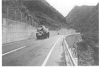
国道494号 改良工事が進んでいる横山 附近
