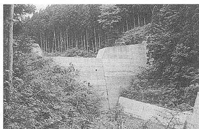
通常荒廃砂防工事 神野川
