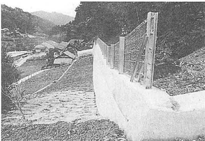
地区復旧治山事業
