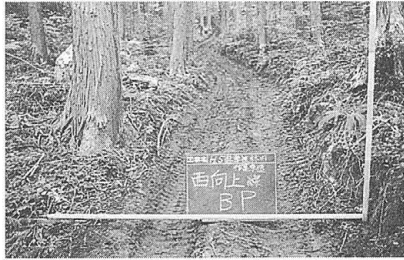
林内作業路（ジャガー道）
