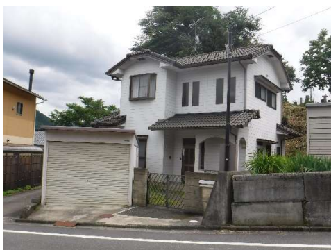
久万住宅（平成 30 年度整備）
