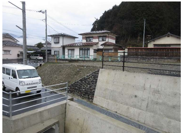
隣接する水路(改修済み)
