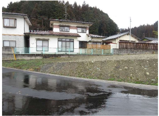
路面勾配に応じて土地造成
