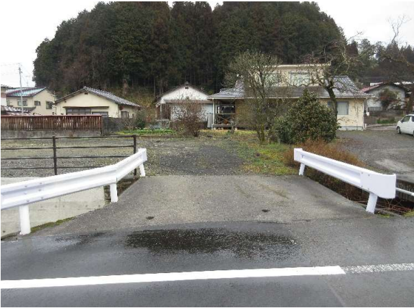
南側の町道から
