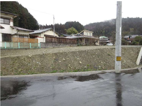
路面勾配に応じて土地造成
