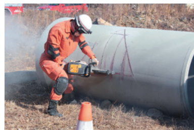
エンジンカッターによる切り込み
