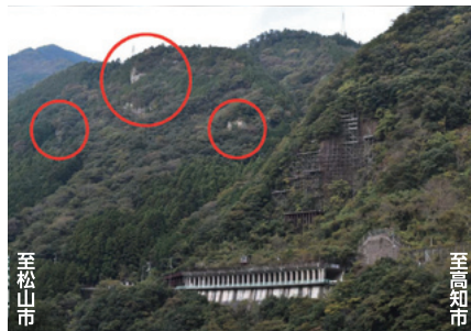
② 県境付近大規模岩盤崩落危険箇所
