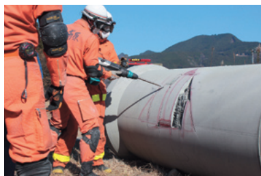
ハンマードリルによるハツリ・穴空け
