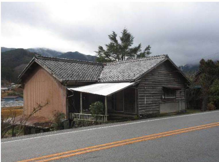
建物全景(国道側)
