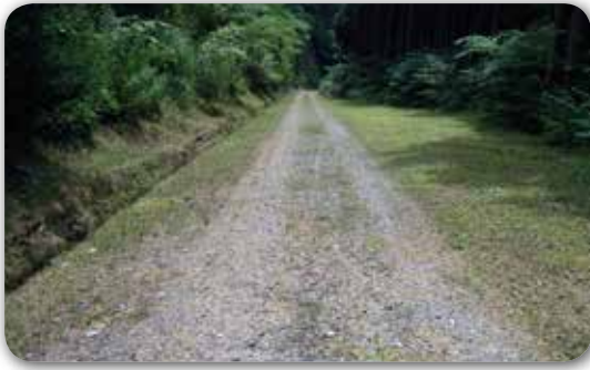
作業終了後の林道
