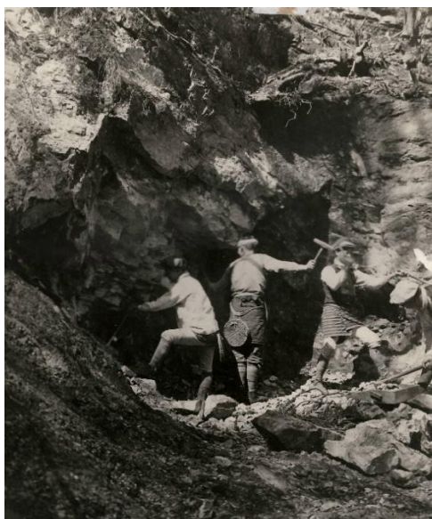
掘削する作業員
