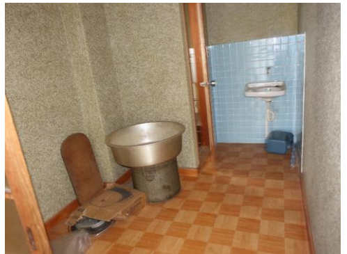
一階奥 トイレ前
