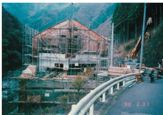
1990年3月31日に撮影された建設中の博物館 (前年4月に第1回建設特別委員会が開かれ、9月には着工)
