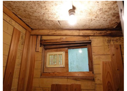
トイレ壁・屋根
