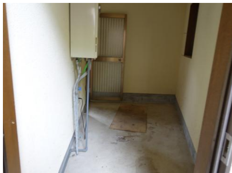
玄関横 収納スペース
