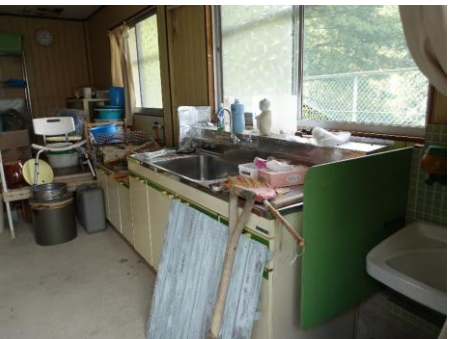
ガレージ地下部分
