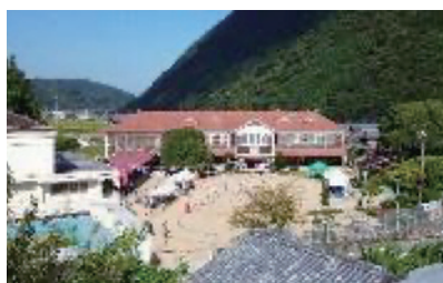
翠小学校の木造校舎
