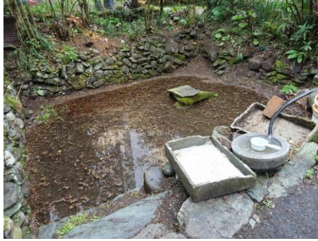
池(水漏れあり)
