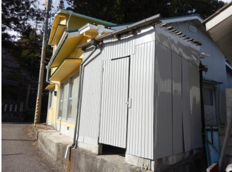
屋外収納スペース(建物裏)
