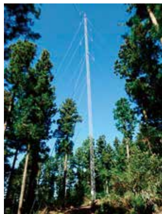
風況調査の鉄塔
