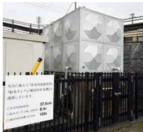
防災センター給水ポンプ
