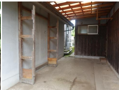
建物裏(勝手口を出たところ)
