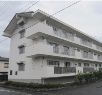
住安住宅外壁等改修工事
