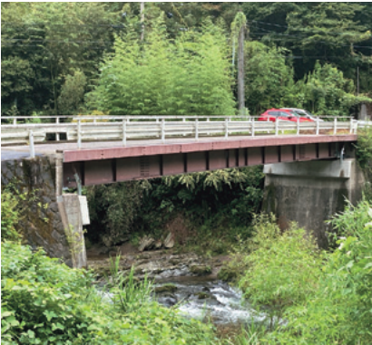
町道橋梁補修工事
