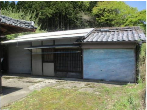
住居横の倉庫
