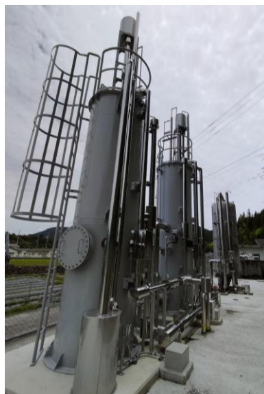
急速ろ過機（重力式） 粒状活性炭ろ過機 畑野川簡易水道千本浄水場
