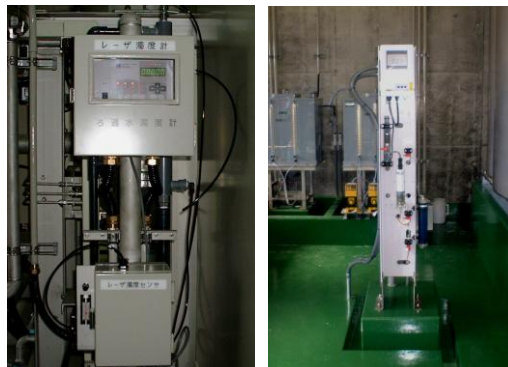
水質監視計器(浄水濁度計/残留塩素計) 直瀬簡易水道上直瀬浄水場
