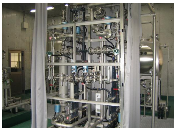
膜ろ過装置（UF膜） 直瀬簡易水道下直瀬浄水場
