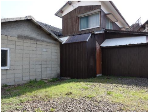
屋根あり物置外観
