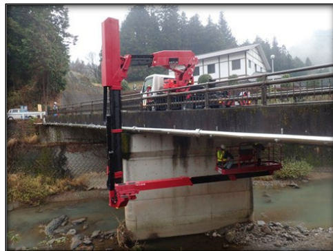
点検状況(宮之前橋)
