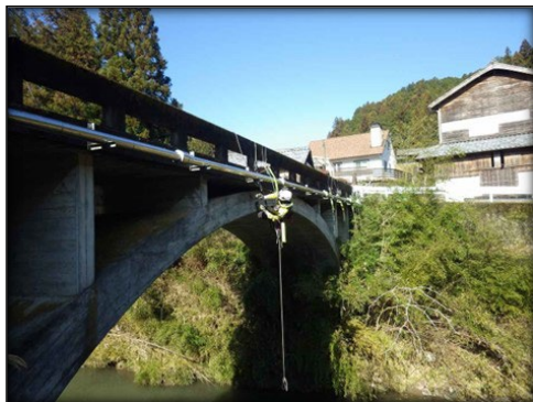
点検状況(久万川橋)
