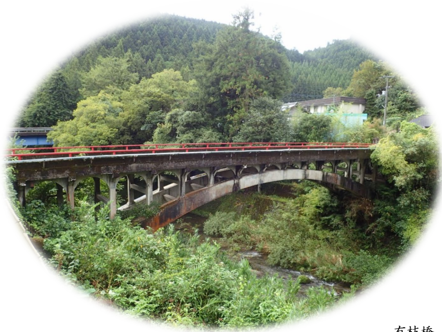
有枝橋 (大正 11 年建設) 近代土木遺産
