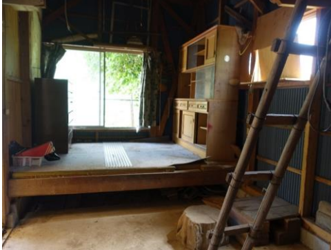
倉庫①(1階内装)
