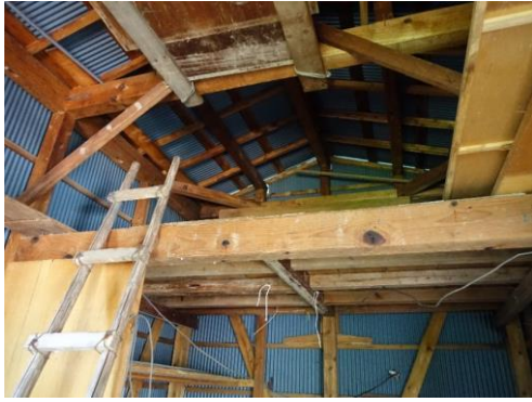
倉庫②(2階内装)
