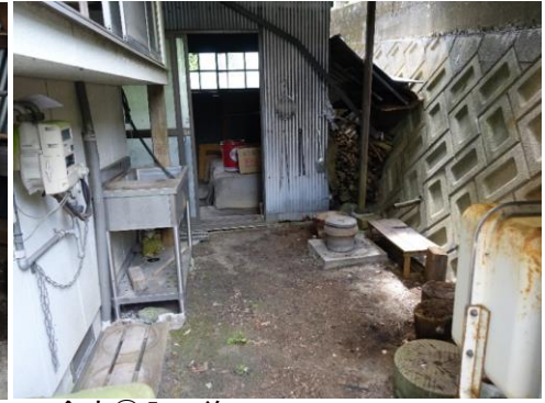
倉庫②入口前
