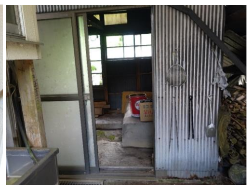
倉庫②の入口
