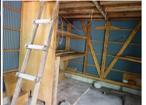
倉庫①(1階内装)
