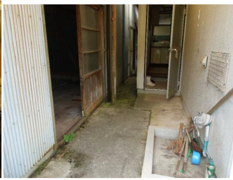
倉庫①の入口
