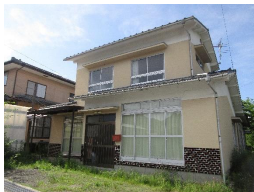
入野住宅（令和2年度整備）
