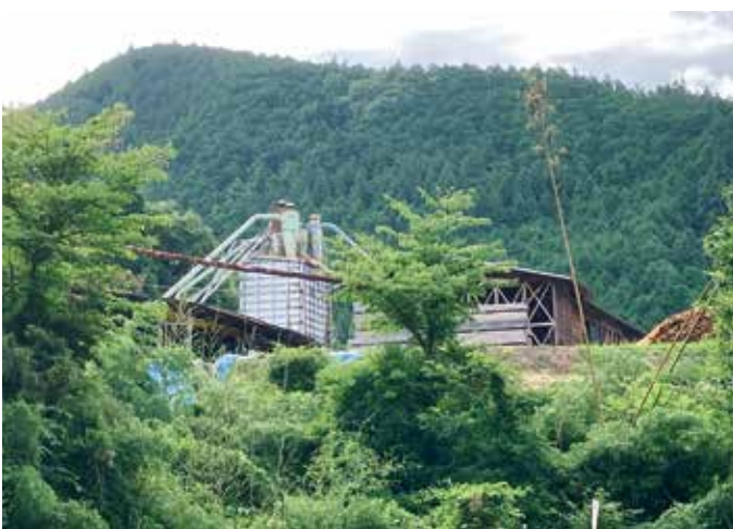
地すべり対策が必要とされる町有地の土羽（菅生）
