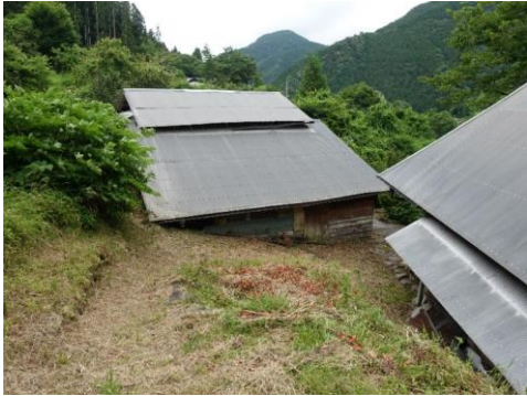
倉庫屋根(左側)
