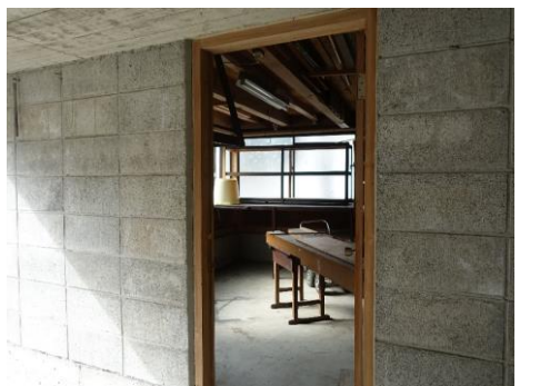
車庫1階作業所①(入口)
