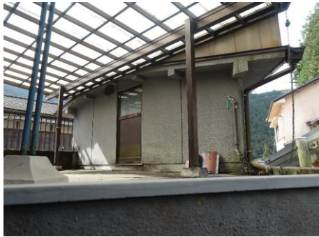
車庫2階洗濯場①
