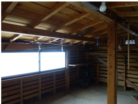
車庫2階作業所②
