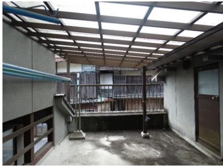
車庫2階洗濯場②
