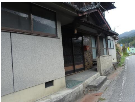
玄関 外側から
