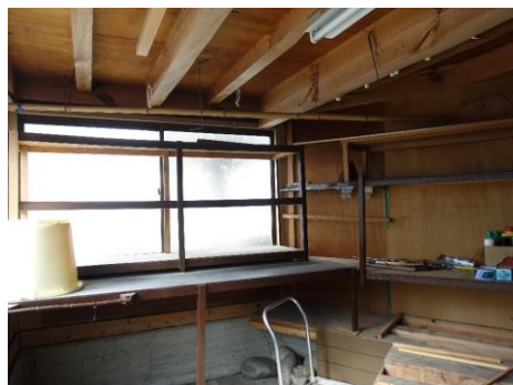
車庫1階作業所②
