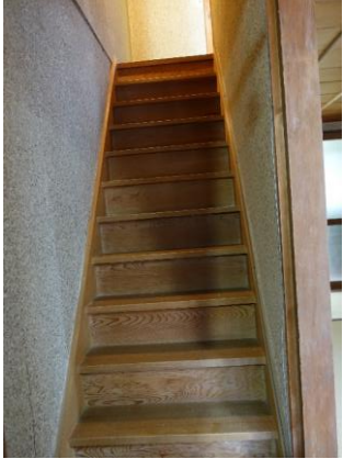
階段①(下から見た写真)
