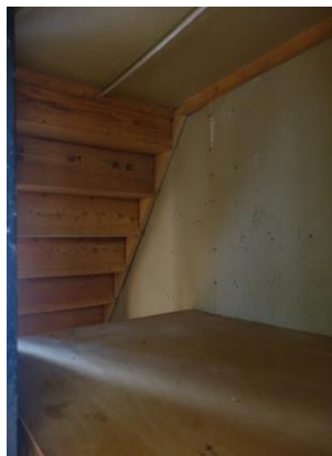
1階和室押し入れ
