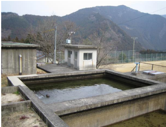
緩速ろ過池 御三戸簡易水道御三戸浄水場
