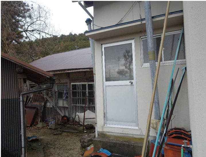
増築部分外観①
