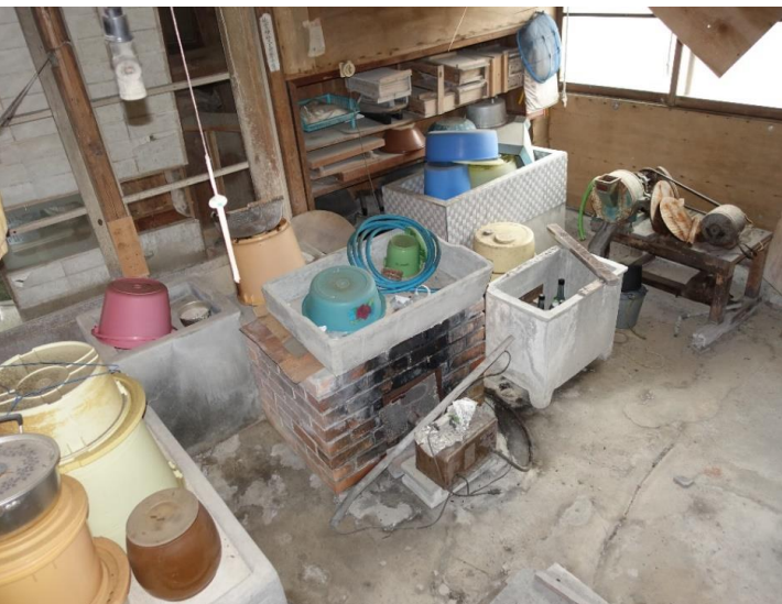
増築部分内側①
