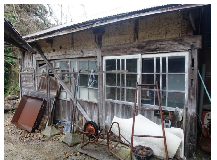
増築部分外観④
