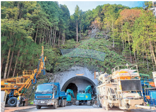
国道440号 小村トンネル
