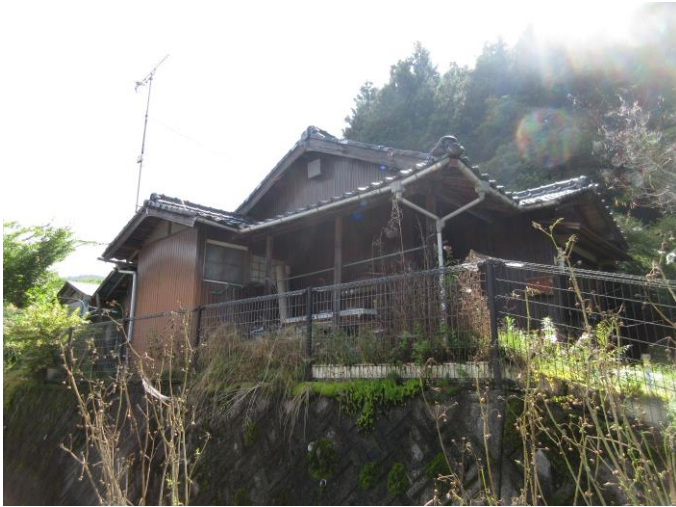
建物全景(その1)
