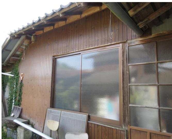
西側外観(和室6帖前)
