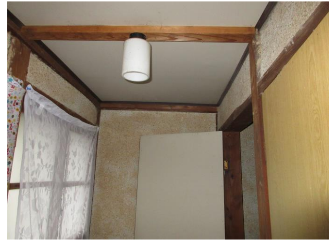
トイレ前・廊下付近(天井)
