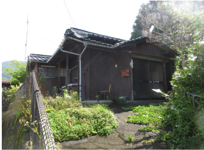
建物全景(その2)
