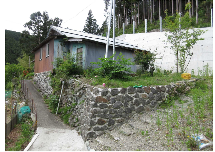
建物全体 (物件B裏・倉庫)
