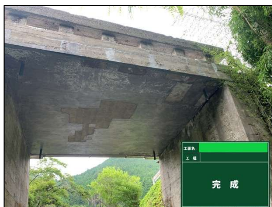
修繕工事実施後
