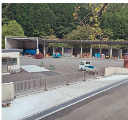
ストックヤード整備事業 （環境衛生センター）
