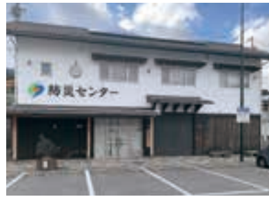
防災センター
