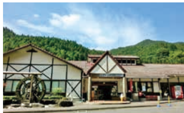
道の駅みかわのリニューアル工事がはじまります。 令和2年4月に再オープンの予定です。
