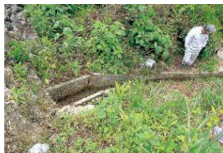
破損した水路
