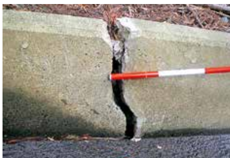
破損した水路
