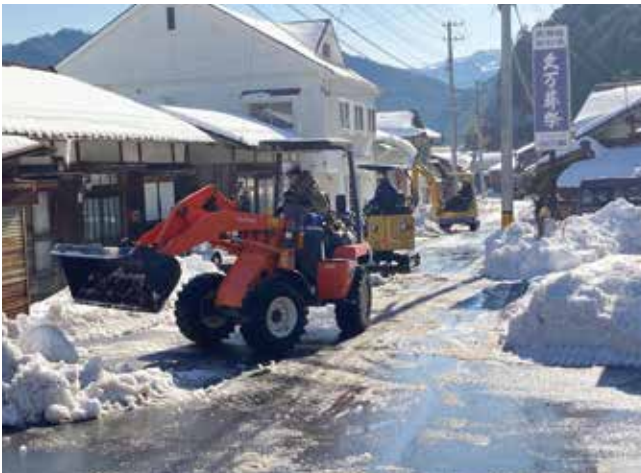
町道除雪作業
