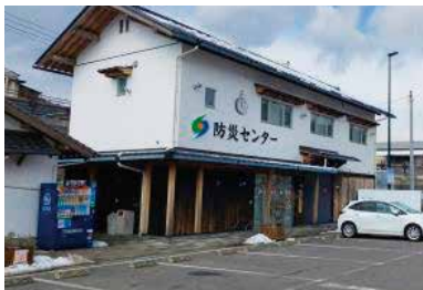
防災センター
