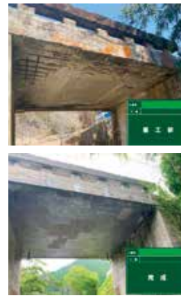
整備前後の橋梁
