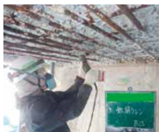
鉄筋ケレン修繕工事
