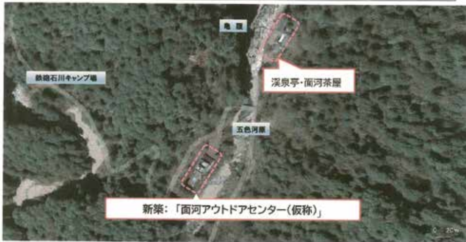
面河アウトドアセンター建設予定地
