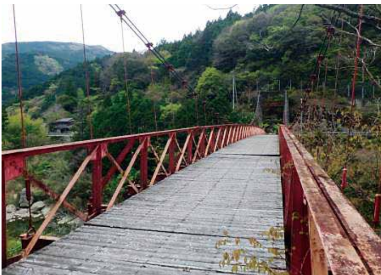
今回修繕予定の平井橋
