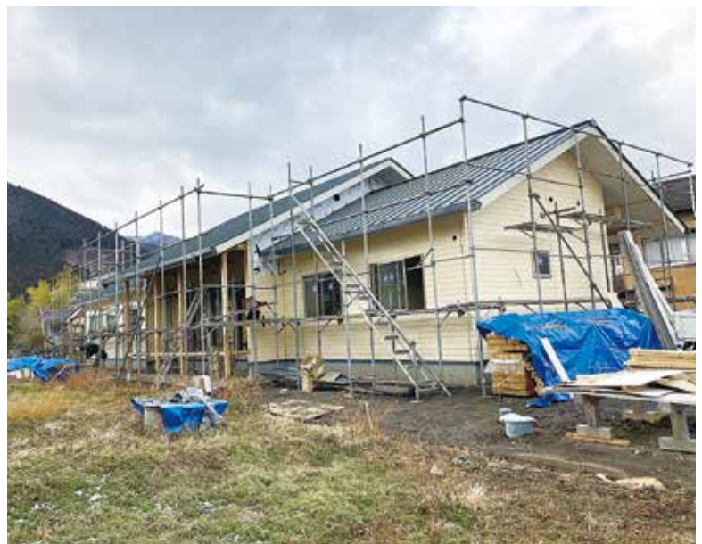
建築中のパステル工房グループホーム
