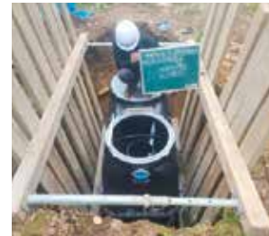
合併浄化槽設置工事
