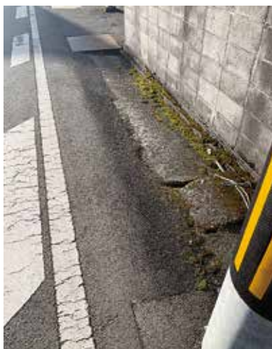
道路脇の状況
