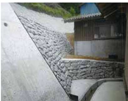
がけ崩れ防災工事
