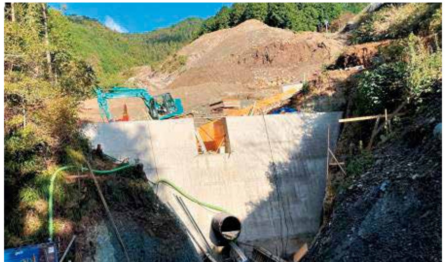
残土処理場土羽台擁壁
